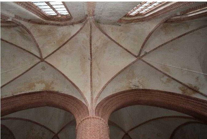
Kirche Risse in den Gewölbedecken
