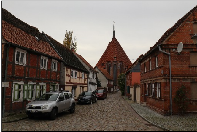
Schadewachten in Werben, Photo. November 2019
